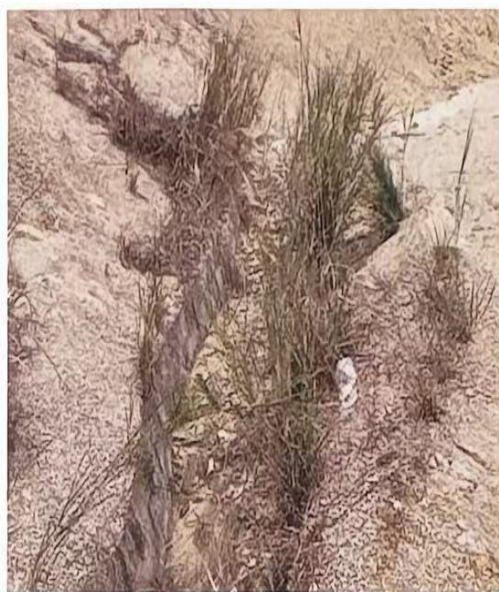
工业场地内排水沟
