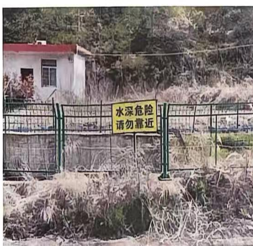
沉淀池防护栏及警示牌
