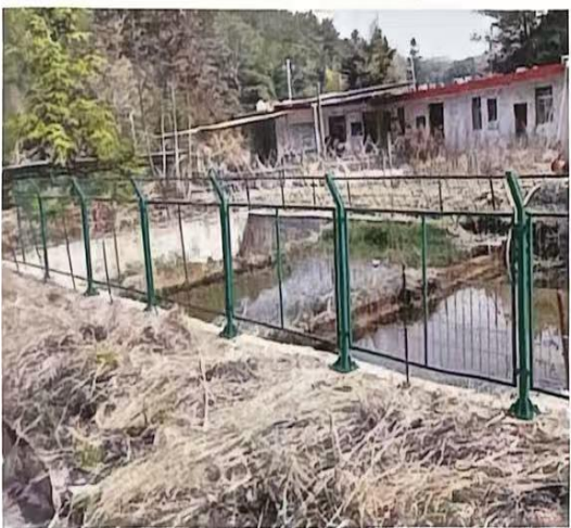
露天采场沉淀池
