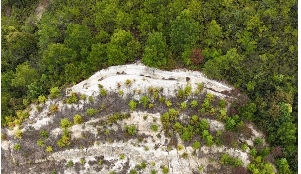
露天采场顶部截水沟及平台植被恢复现状
