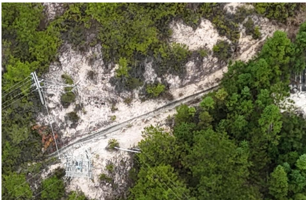
工业场地顶部截水沟
