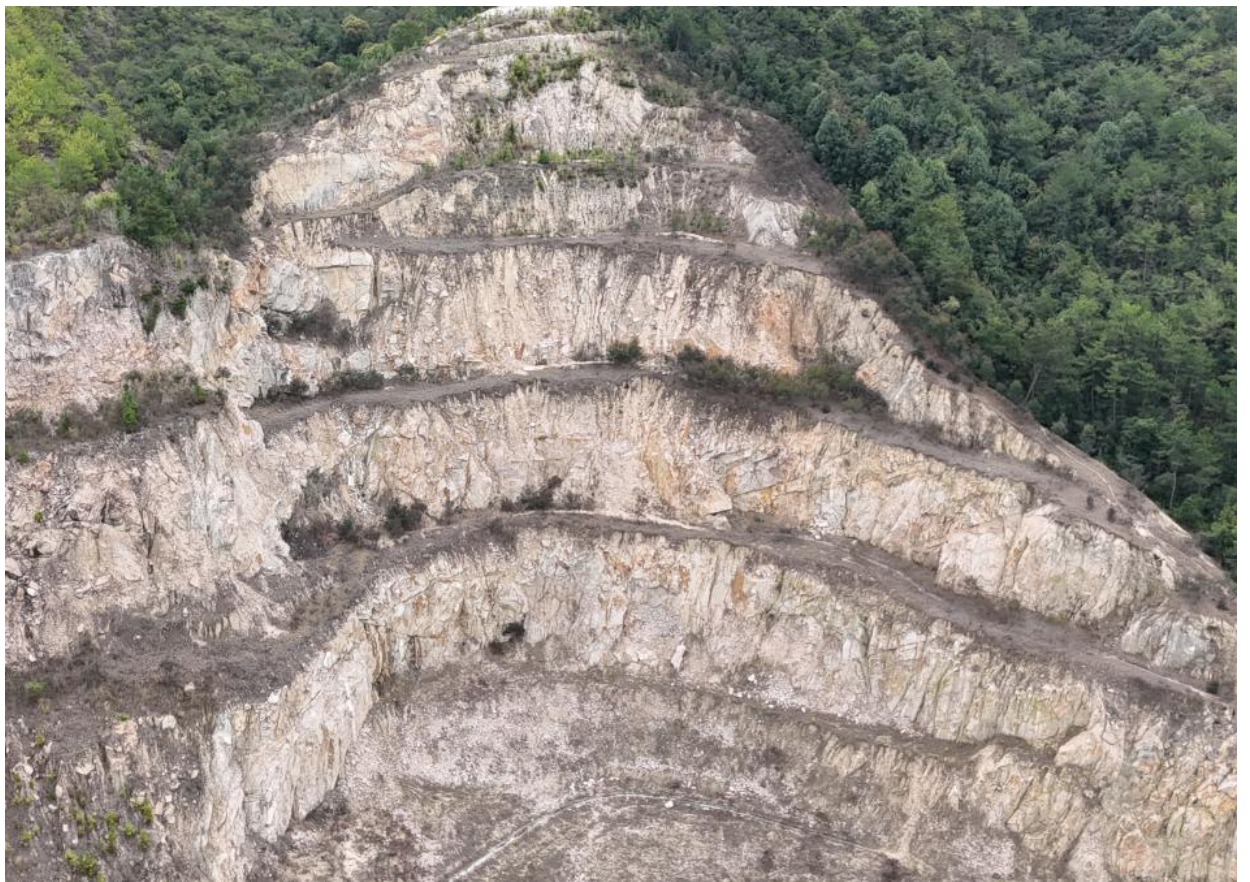
露天采场各平台内排水沟
